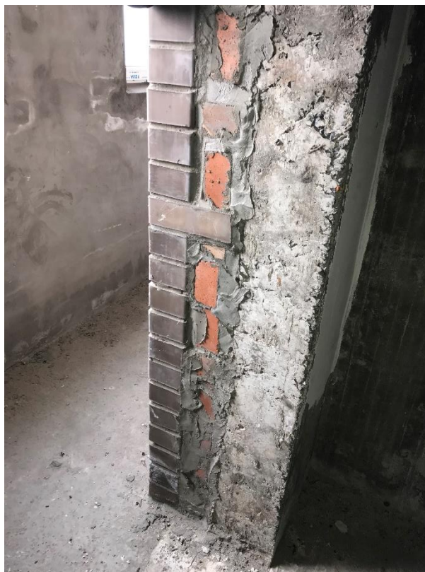
Фото 54. Перевязка и кладка торцевых участков (откосов дверных проемов) наружных стен, утепленных минераловатным утеплителем
