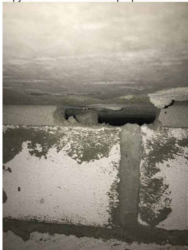
Фото 51. Крепление перегородок к перекрытиям (перегородка под плитой)
