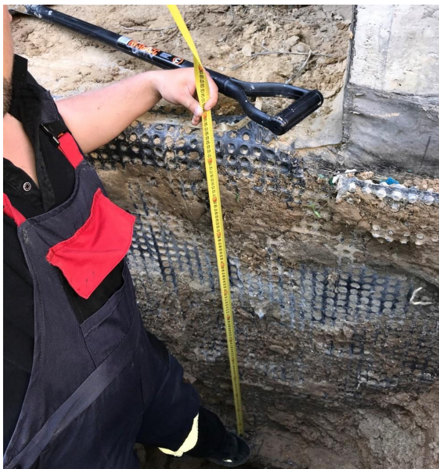
Фото 44. 18-этажная часть. Шурф по оси Г. Определение толщины (высоты) фундаментной плиты.
