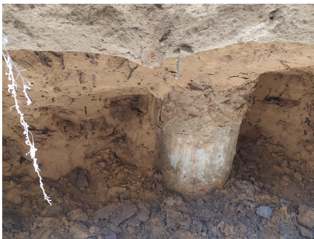
Фото 45. Бурунабивная свая усиления основания.
