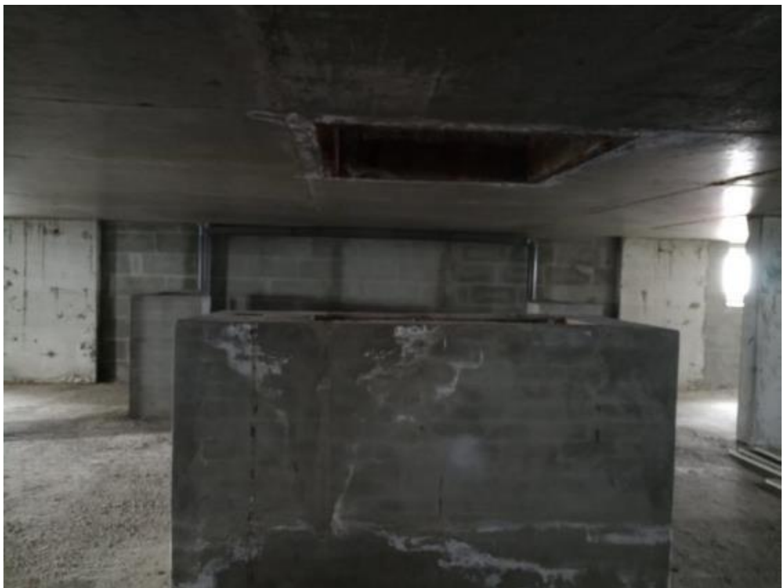
Фото 15. Общие виды технического этажа здания, 18-этажная часть
