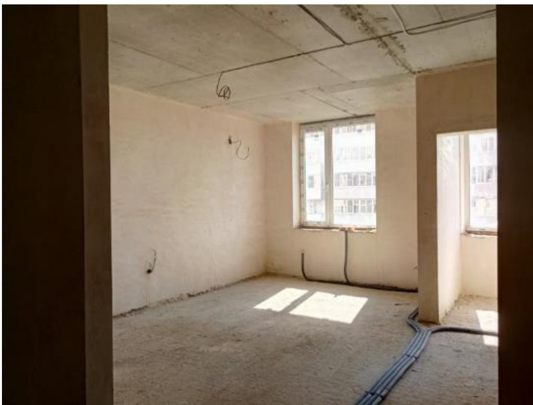
Фото 6. Общие виды помещений здания , 18-этажная часть
