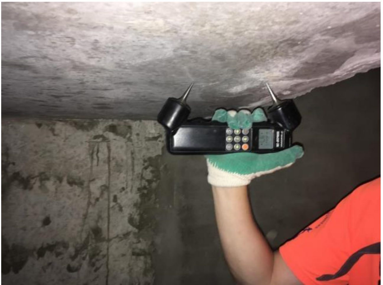
Фото 38 Определение прочности бетона перекрытия ультразвуковым методом
