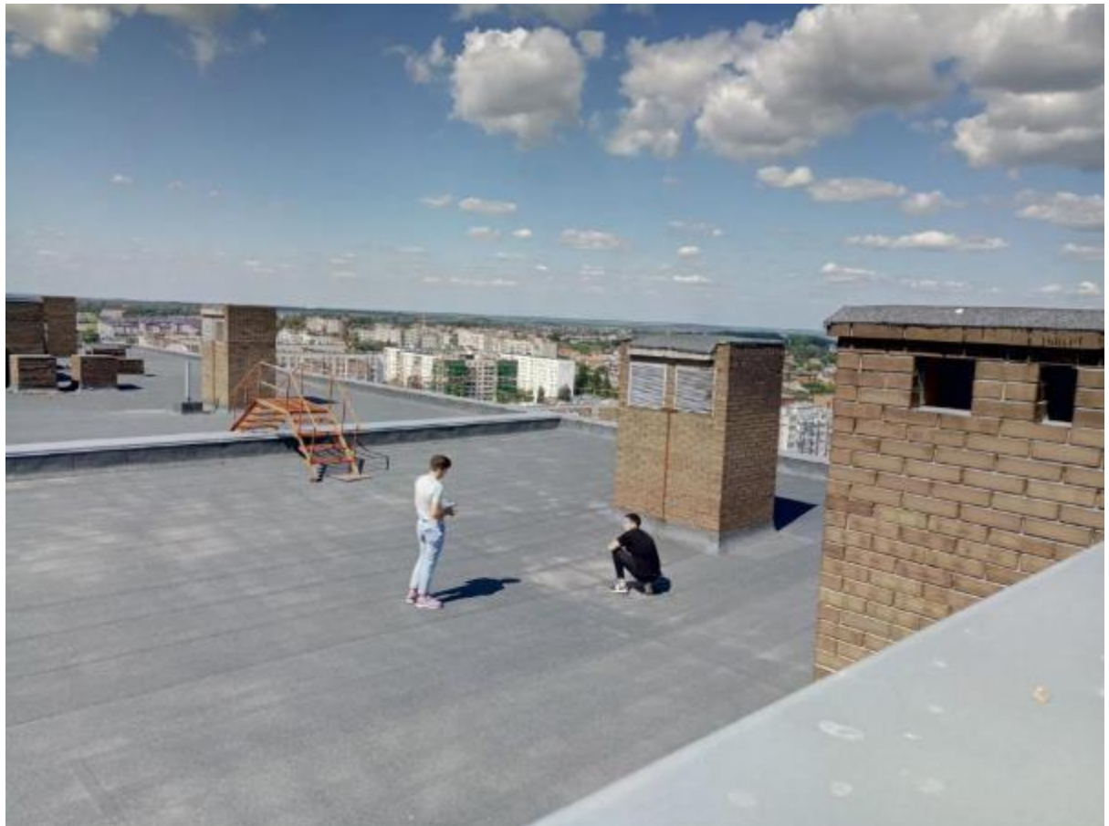
Фото 26. Общий вид кровли 18-этажной части здания в осях 1-20, А-Д
