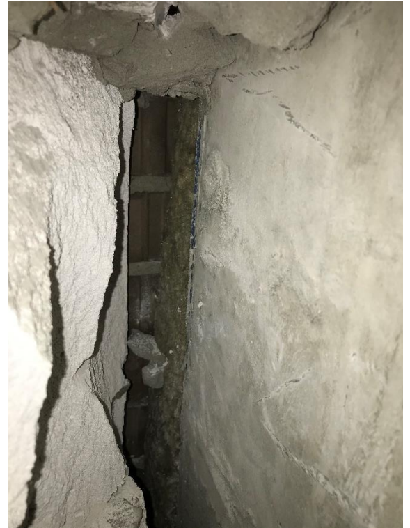
Фото 48. Состав наружной стены: газоблок, минераловатный утеплитель, облицовочный кирпич.
