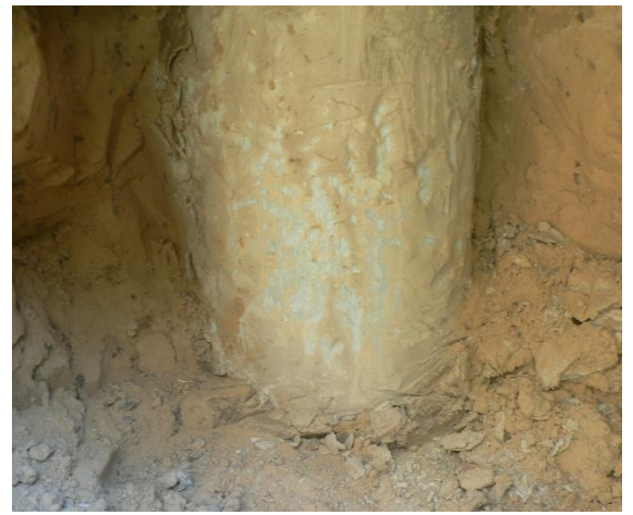
Рисунок 6. Внешний вид железобетонной сваи № 2
