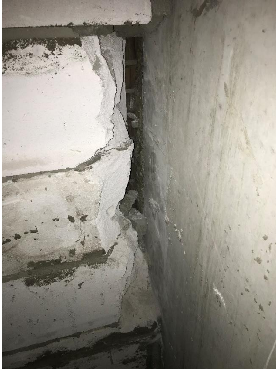
Фото 48. Состав наружной стены: газоблок, минераловатный утеплитель, облицовочный кирпич.
