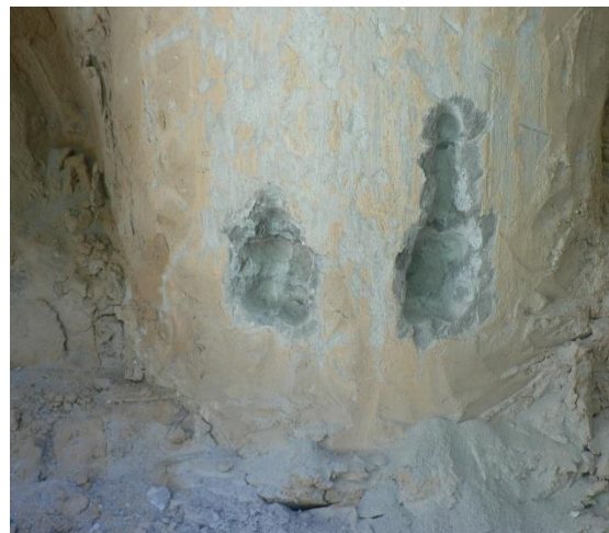
Рисунки 8 и 9. Площадки на боковых поверхностях монолитных железобетонных свай построечного изготовления №№ 1 и 2 для установки сейсмических датчиков измерителя «ИДС - 1», выполненные с применением перфоратора ударно-вращательного действия
