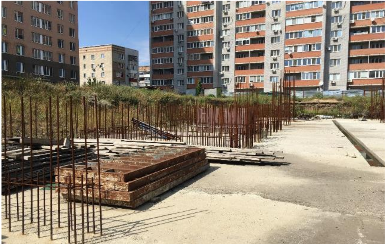
Фото 18. Общий вид конструкций фундамента 9-этажной части
