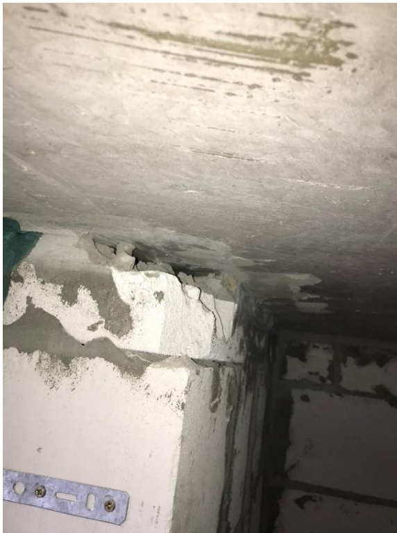
Фото 50. Крепление наружных стен к плите перекрытия
