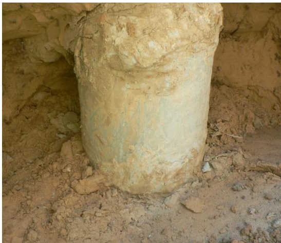
Рисунок 5. Внешний вид железобетонной сваи № 1
