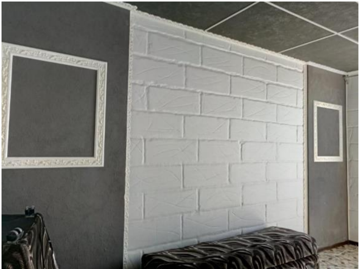
Фото 9. Общие виды помещений здания, 18-этажная часть
