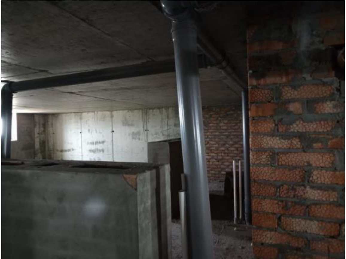
Фото 16. Общие виды технического этажа здания, 18-этажная часть
