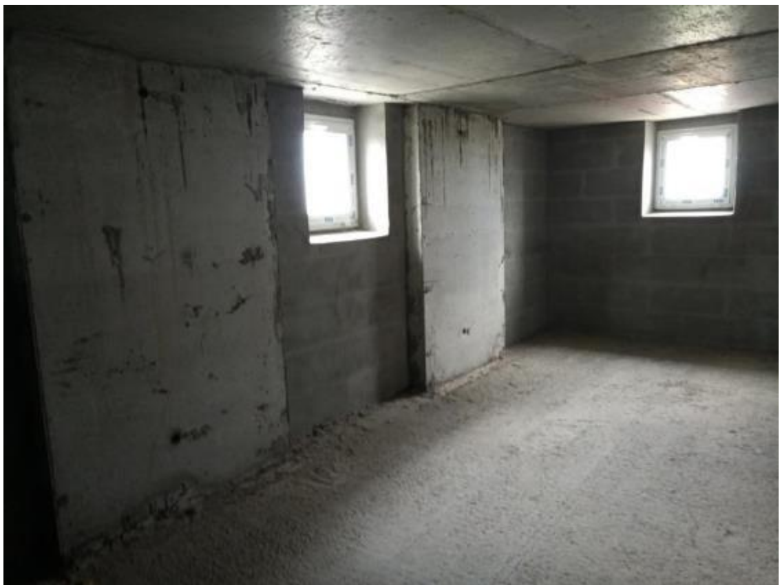
Фото 17. Общие виды технического этажа здания, 18-этажная часть
