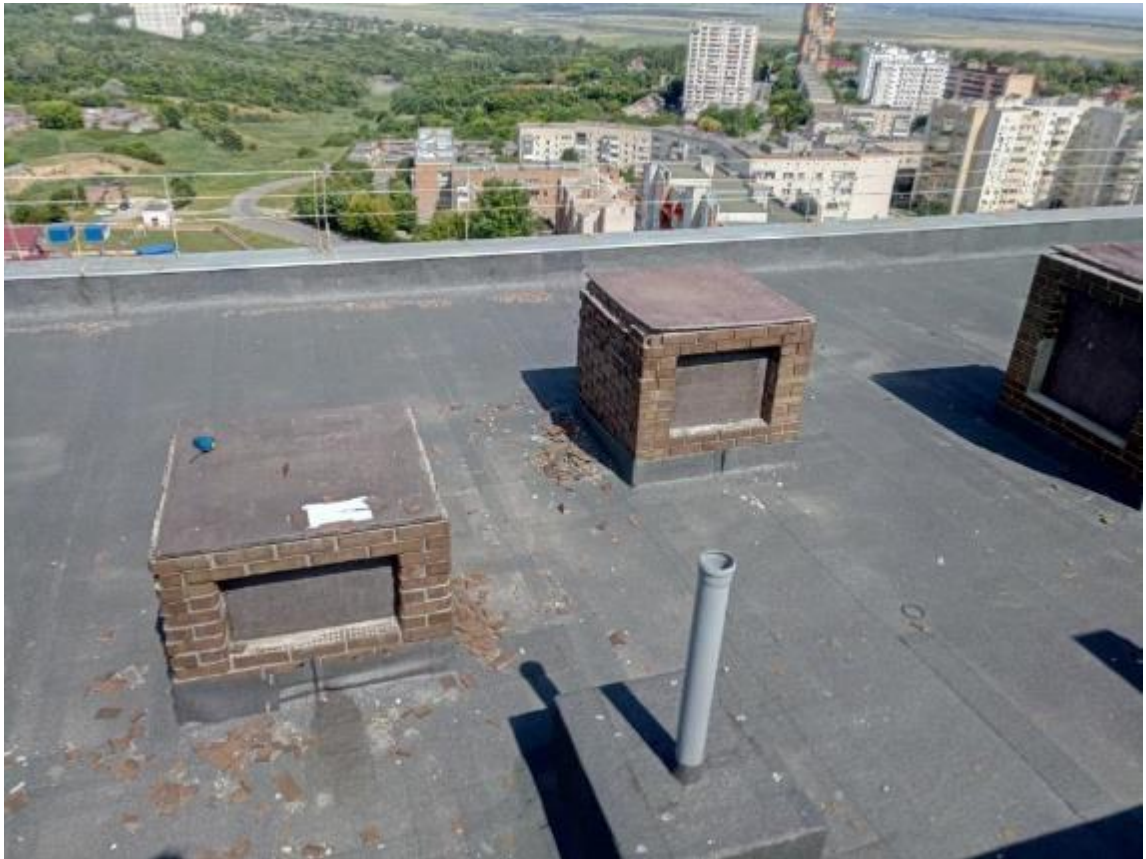
Фото 25. Общий вид кровли 18-этажной части здания в осях 1-20, А-Д.
