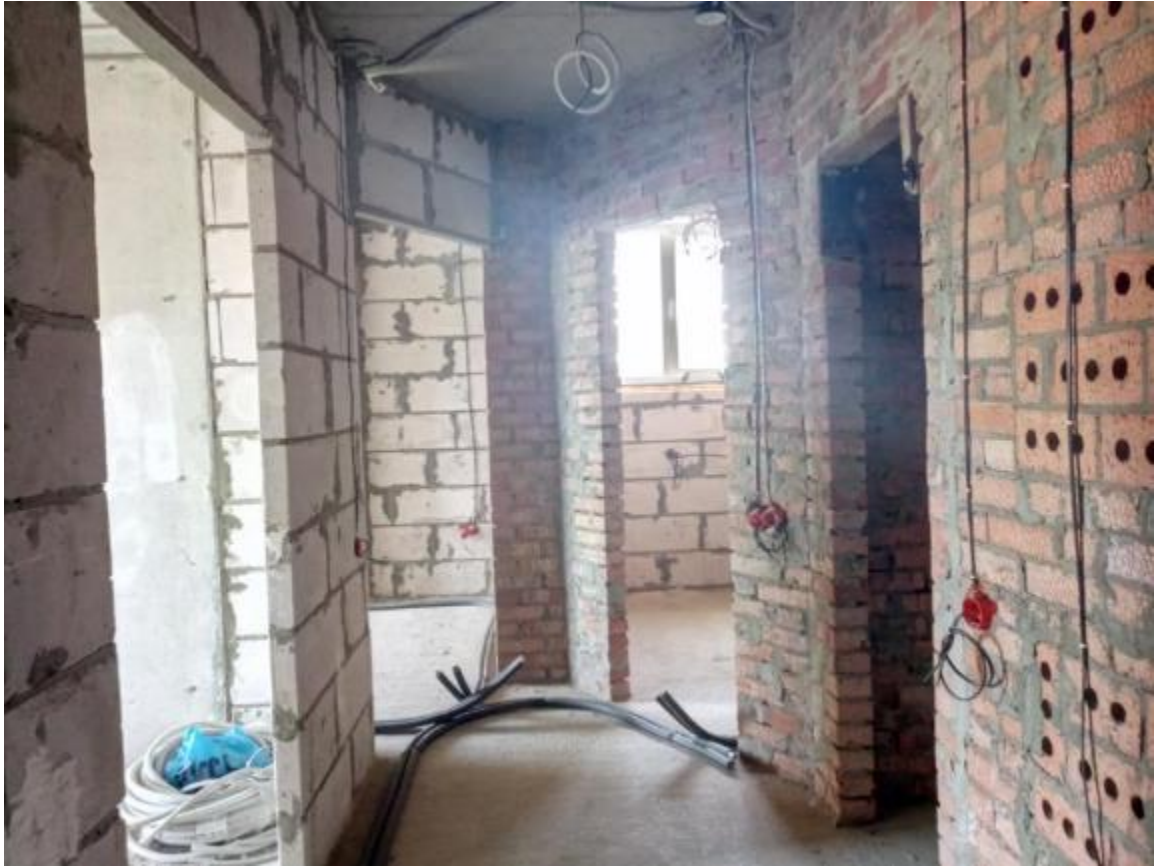
Фото 8. Общие виды помещений здания , 18-этажная часть
