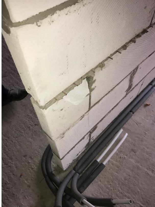
Фото 46. Армирование перегородки из газоблока.
