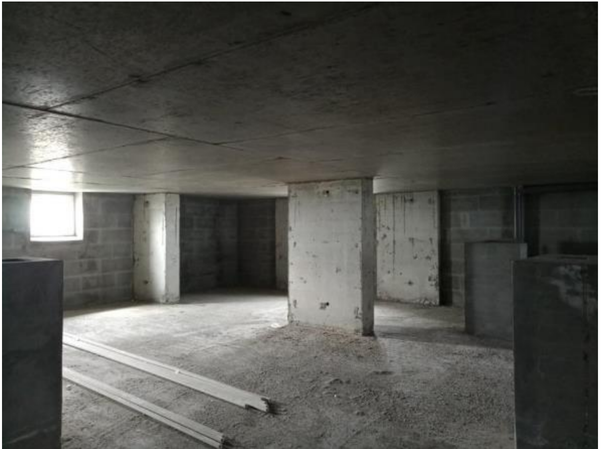
Фото 14 Общие виды технического этажа здания, 18-этажная часть
