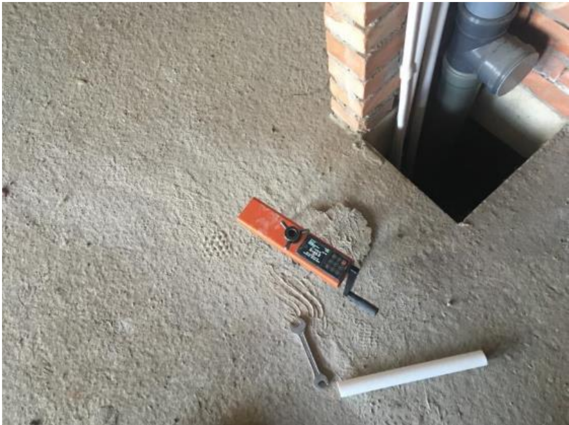
Фото 41. Определение прочности бетона методом отрыва со скалыванием
