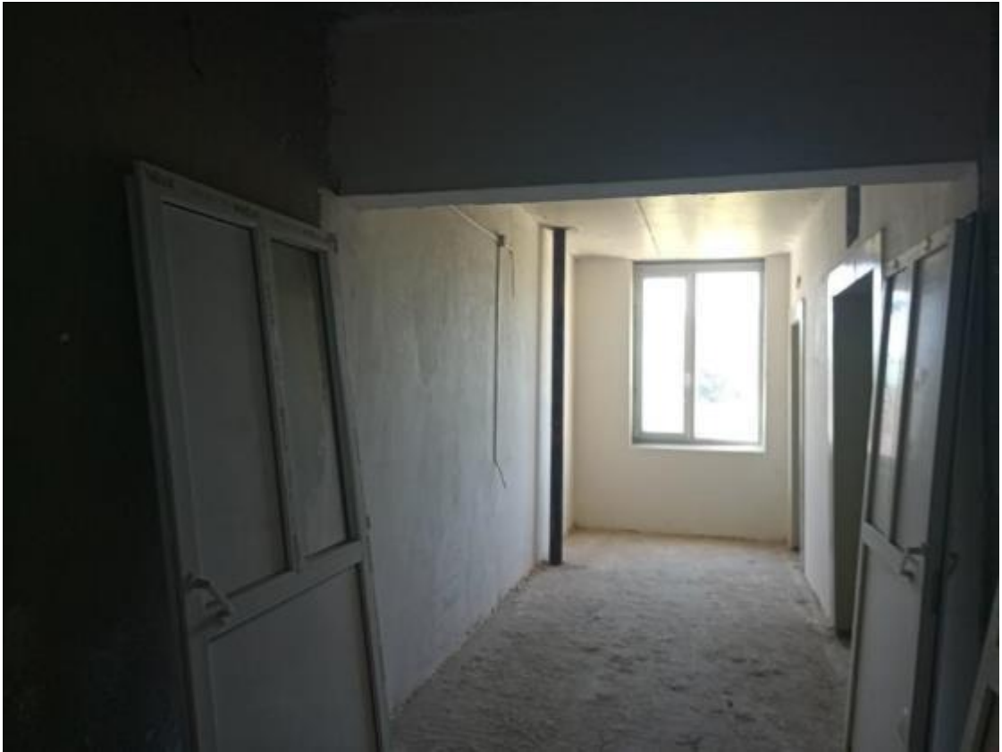
Фото 10. Общие виды помещений лифтового холла здания, 18-этажная часть
