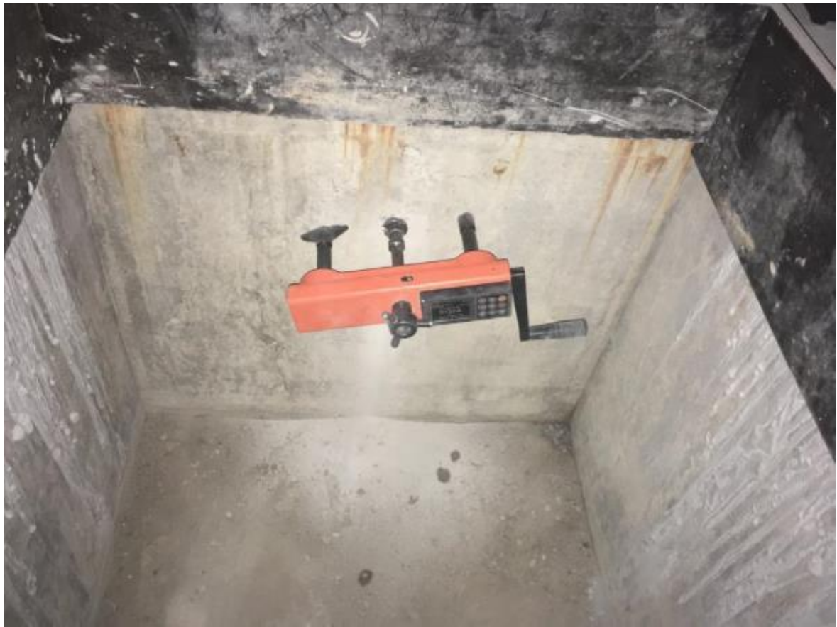
Фото 42. Определение прочности бетона методом отрыва со скалыванием
