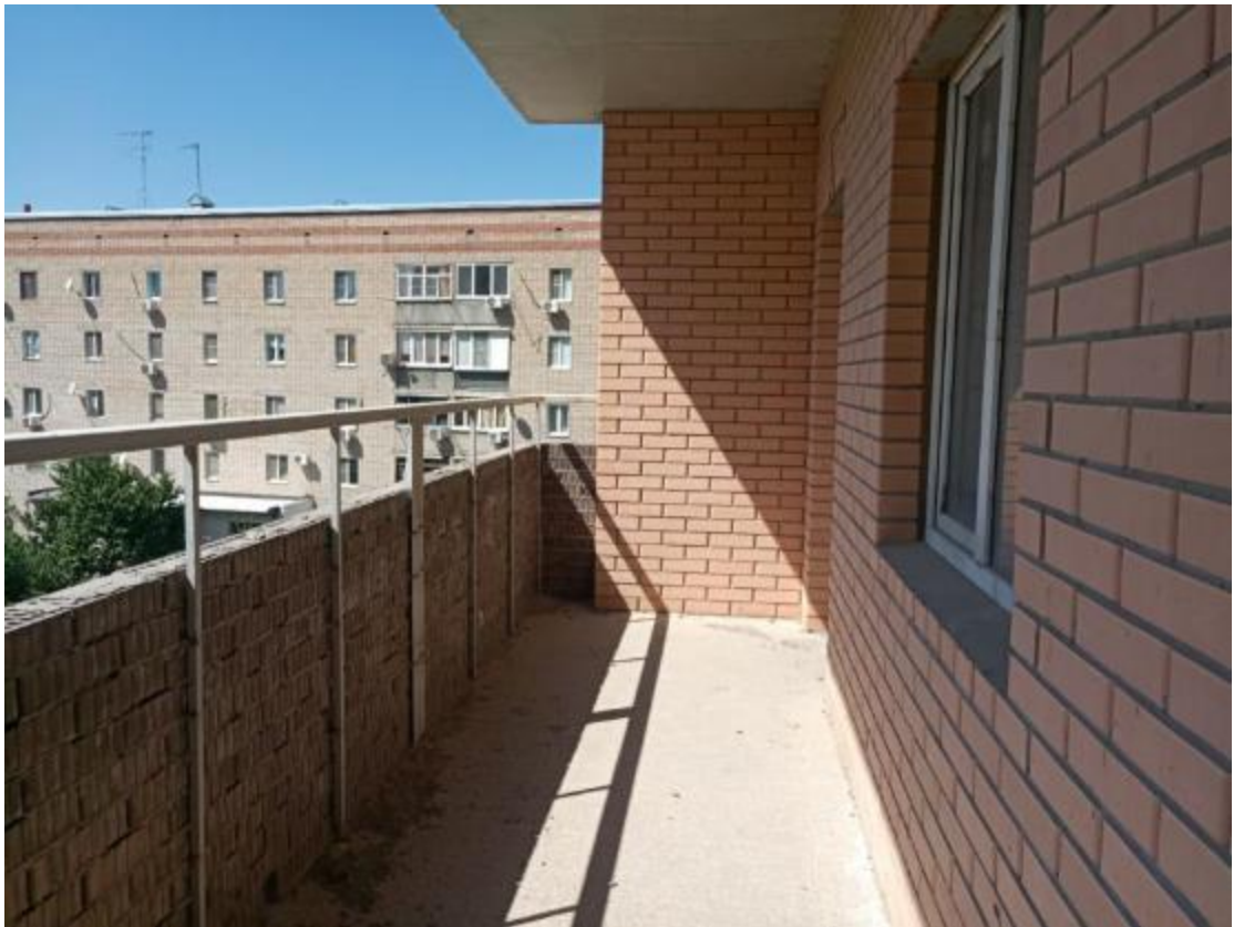
Фото 11. Общие виды незадымляемой лестницы здания, 18-этажная часть
