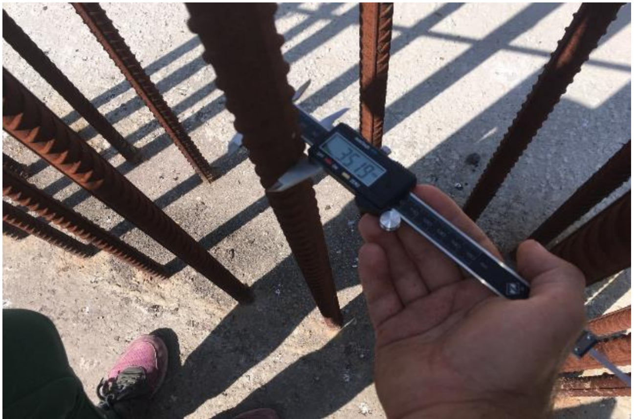
Фото 19. Обмерные работы, фундамент 9-этажной части
