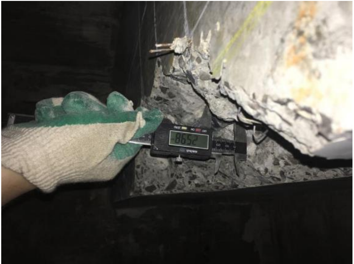
Фото 31. Обмерные работы (перекрытие 18-этажной части здания в осях 1-20, А-Д)
