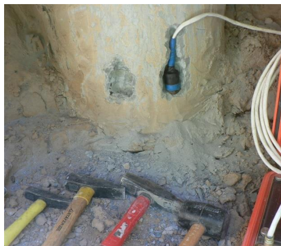
Рисунок 16. Сейсмический датчик установлен на предварительно выполненную в теле железобетонной сваи № 2 горизонтальную площадку. Измеритель «ИДС - 1» подготовлен к проведению измерений
