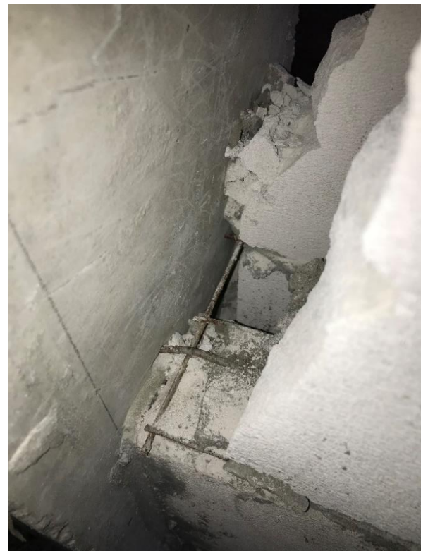
Фото 49. Анкеровка межквартирных перегородок из газоблока.
