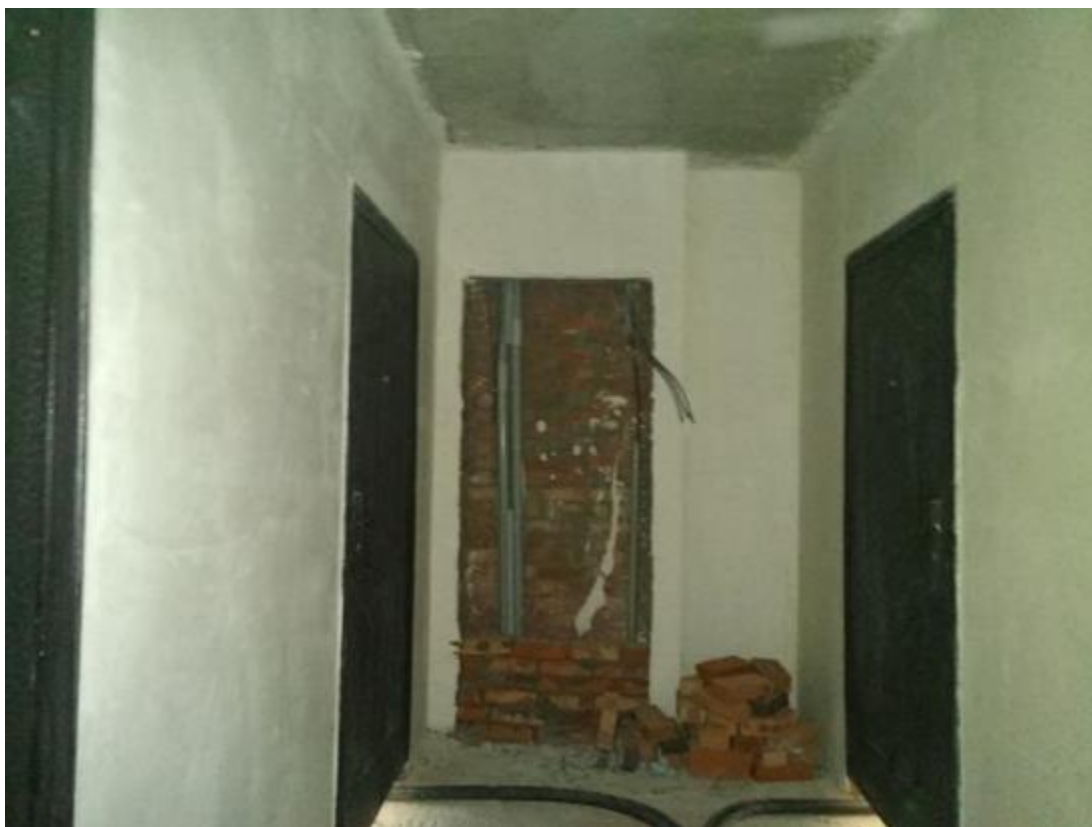
Фото 12. Состояние инженерных коммуникаций, 18-этажная часть
