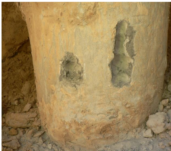
Рисунки 8 и 9. Площадки на боковых поверхностях монолитных железобетонных свай построечного изготовления №№ 1 и 2 для установки сейсмических датчиков измерителя «ИДС - 1», выполненные с применением перфоратора ударно-вращательного действия
