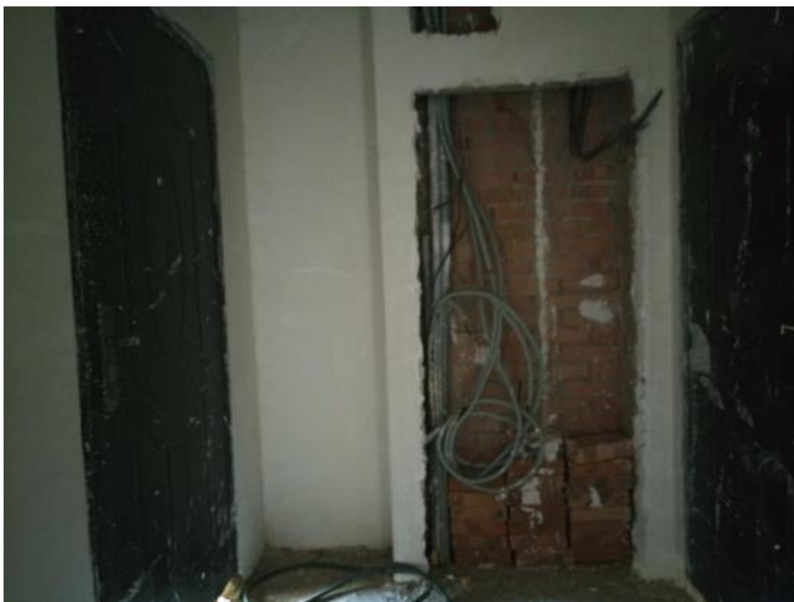
Фото 13. Состояние инженерных коммуникаций, 18-этажная часть
