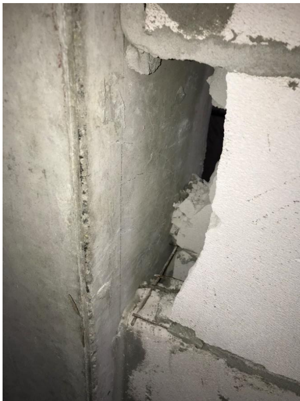
Фото 49. Анкеровка межквартирных перегородок из газоблока.
