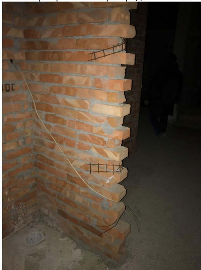
Фото 47. Армирование перегородки из кирпича
