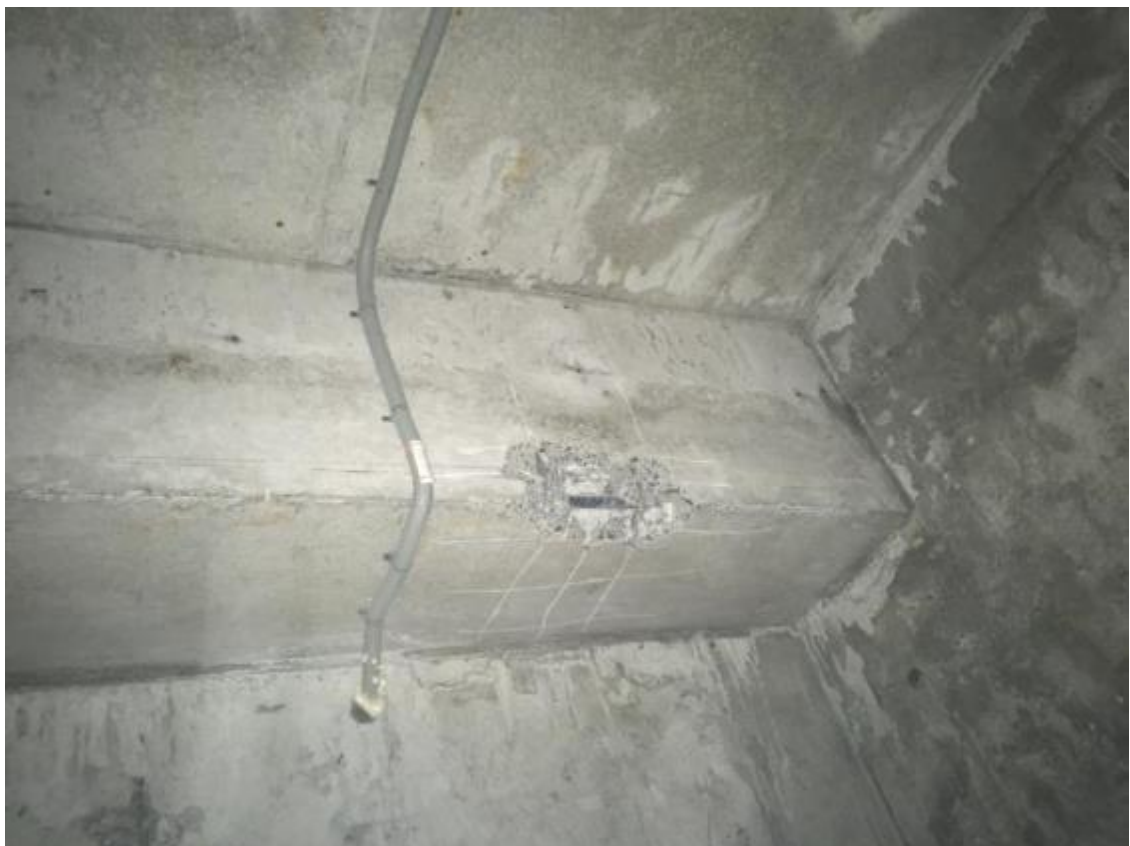
Фото 32. Обмерные работы (перекрытие 18-этажной части здания в осях 1-20, А-Д)
