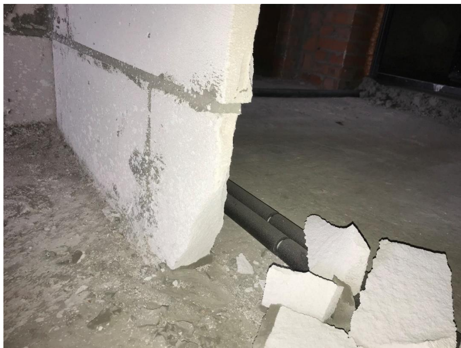
Фото 52. Крепление перегородок к перекрытиям (перегородка на плите)
